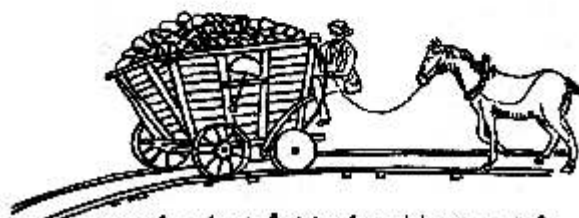
8 - Vue d'ensemble: voiture roulant sur chemin de bois et munie d'un frein. (MADAME, Le sort d'exploiter les mines, 1768).
